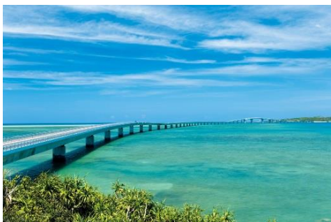
全長 3 5 4 0 m 伊良部大橋 海がきれいです。
